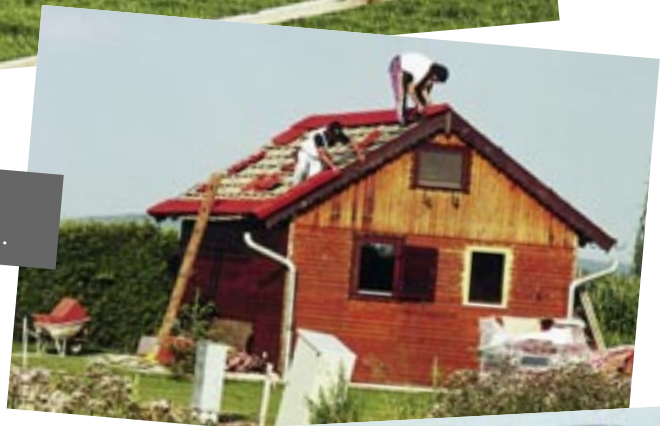
1993 - Die ersten Häuser werden fertiggestellt ...
