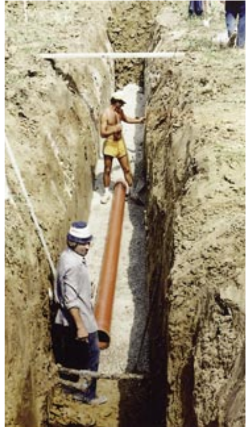
Wasserleitungsrohre werden verlegt
