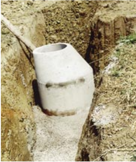
Der Bau der Ringsammelleitung mit Anschluss an den Eisberghauptkanal
