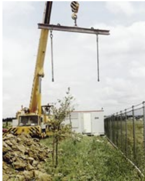
Die Verlegung der Stromkabel und der Wasserleitung
